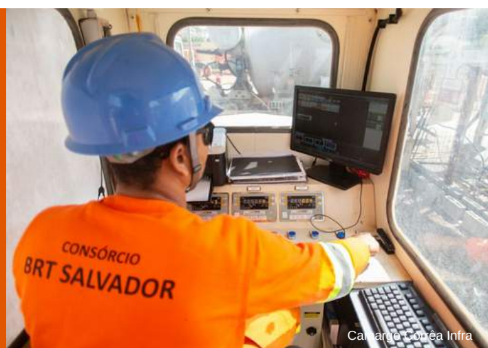
Operador de Máquinas da Obra BRT Salvador-BA
