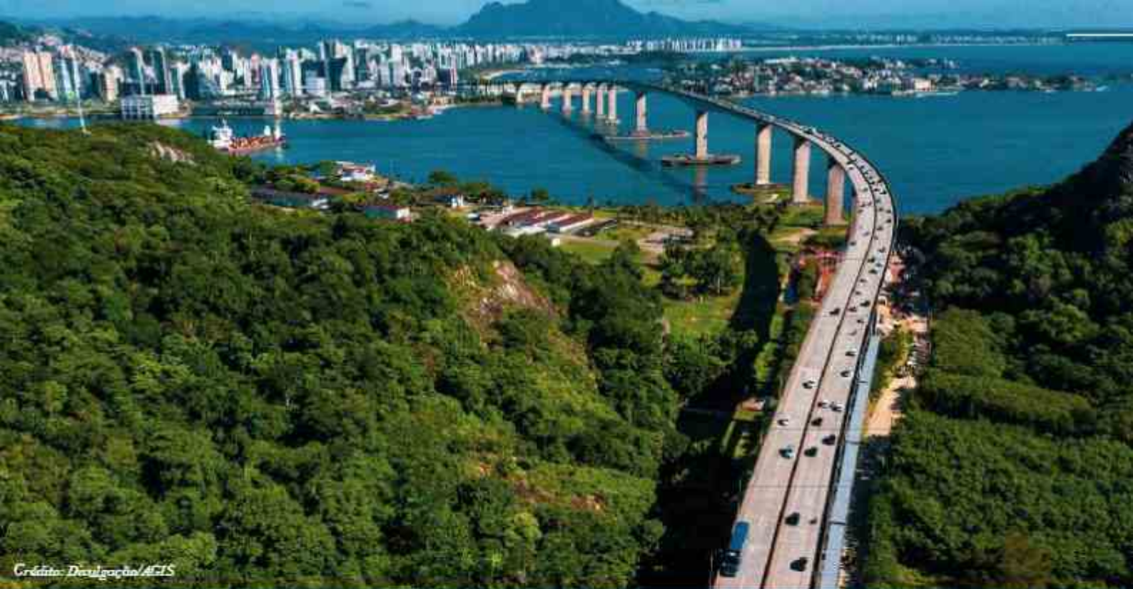
Ciclovias da Vida e alargamento da ponte rodoviária, com implantação da 3ª faixa de rolamento, ligando Vitória a Vila Velha, no Espírito Santo, obra executada pelo Consórcio Ferreira Guedes Metalfix
