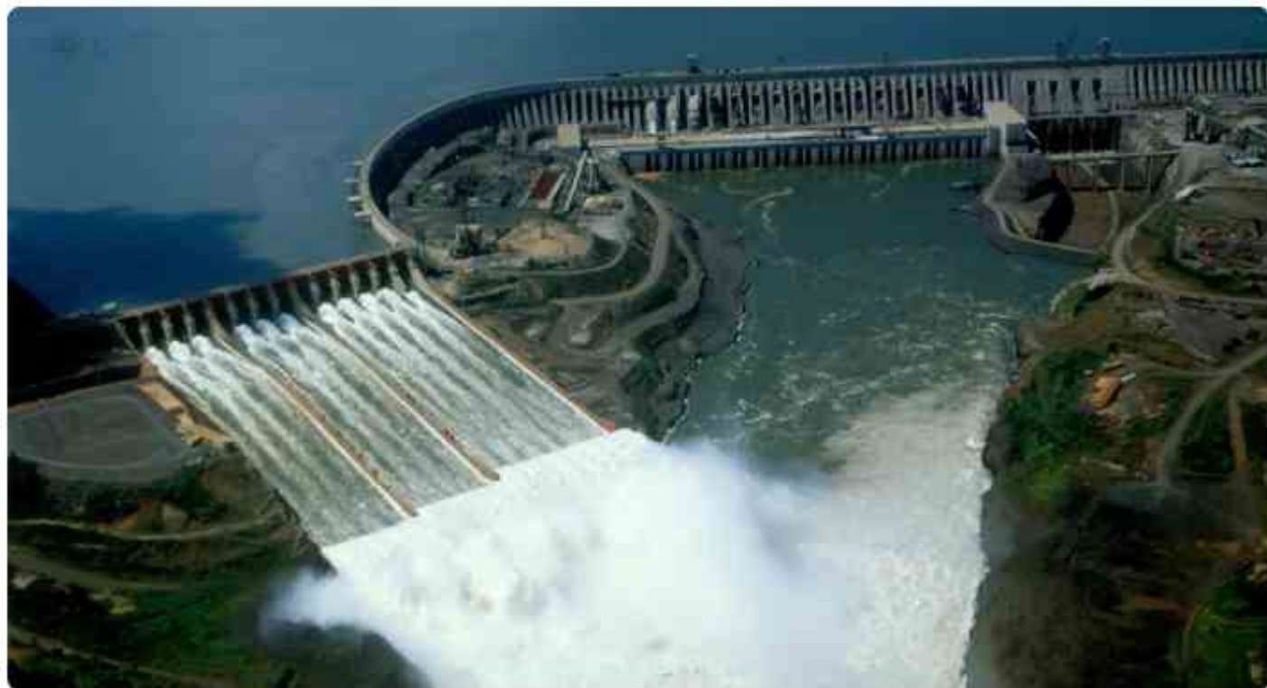
UHE Itaipu, uma das obras emblemáticas realizadas pela engenharia brasileira.
